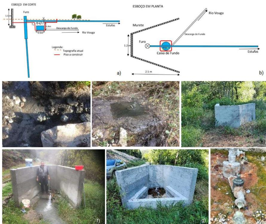
**Figura 3** – Elementos de melhoria do sistema de captação do Furo SDV1 após as cheias: a) e b) esboços sobre intervenções propostas; c) e d) fotos da cabeça do furo assoreada após a cheia; e) a h) fotos após alguns melhoramentos.
