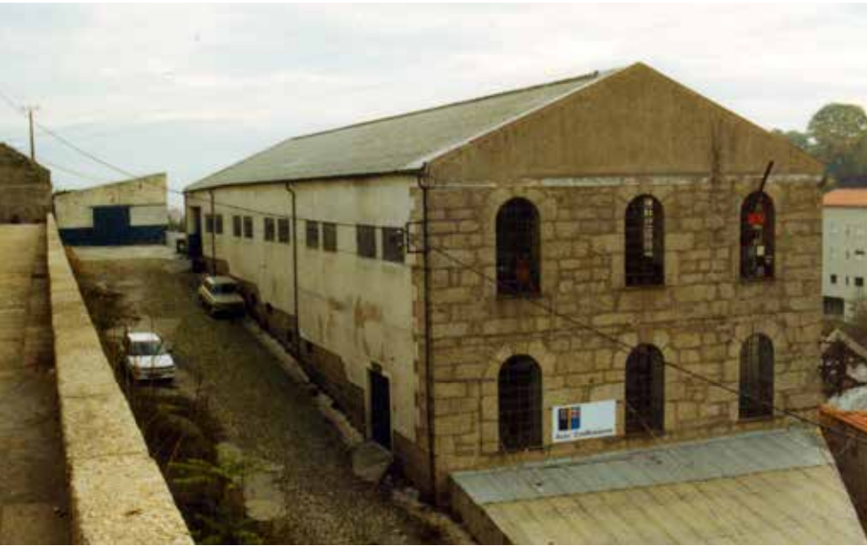
UBI, Faculdade de Ciências da Saúde, Instalações provisórias
