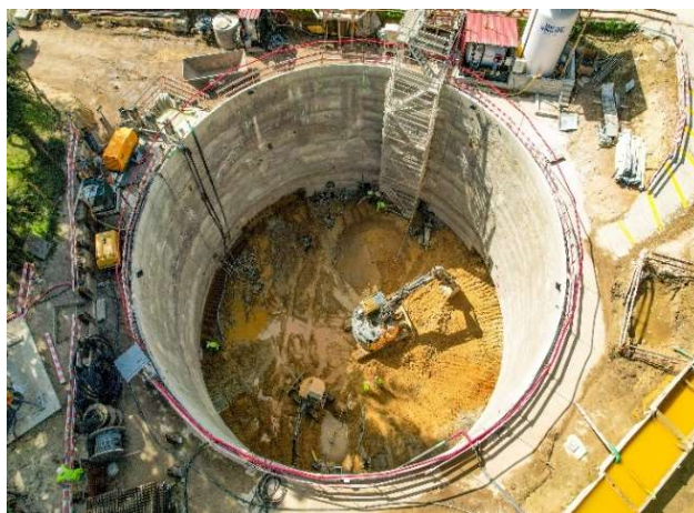
Figura 1 – Vista aérea do poço de saída de emergência (Metro do Porto, 2022).
